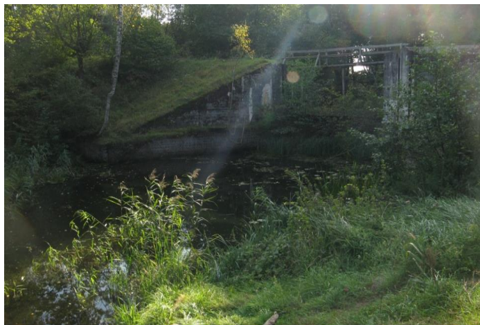
Fot. 2. Jaz – obiekt MRU nr 712 (fot. T. Pilczuk ** ) Fig. 2. Jaz – MRU object No. 712 (phot. T. Pilczuk ** )
