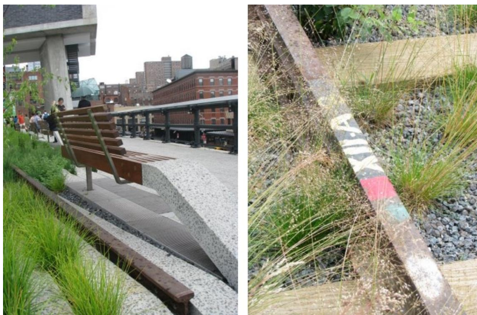
Rys. 2. Stare szyny wkomponowane w nową nawierzchnię (M. Lizurej 2009)
