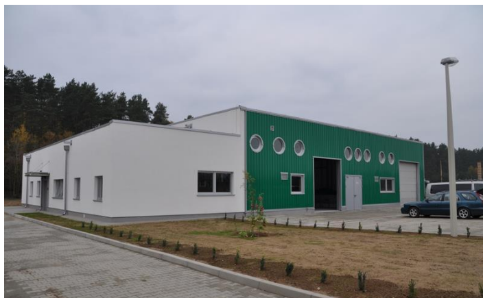
Fot. 1. Widok na oczyszczalnię ścieków w Gronowie Phot. 1. View of the wastewater treatment plant in Gronowo
