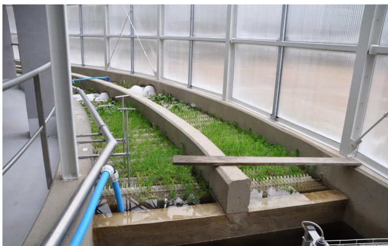
Fot. 3. Widok na lagunę hydroponiczną Phot. 3. View of hydroponic lagoon
